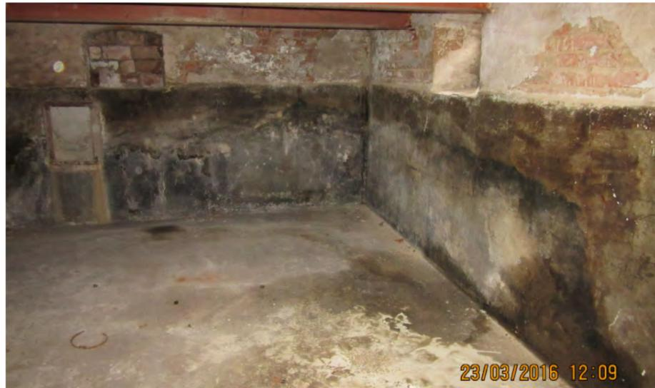
IMG\_0049 Keller mit bleihaltiger Bodenplatte
