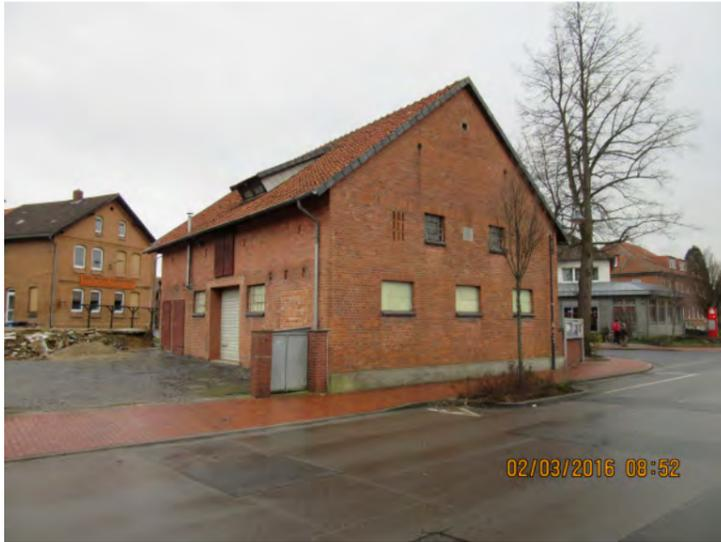
IMG\_0022 Lagerhaus 1: Gaube + Dachwinkel Asbestzement
