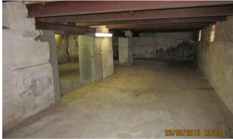
IMG\_0050 Keller mit bleihaltiger Bodenplatte
