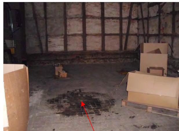
Lage Bohrpunkt (dunkle Farbe: Bohrwasser, kein Öl)
