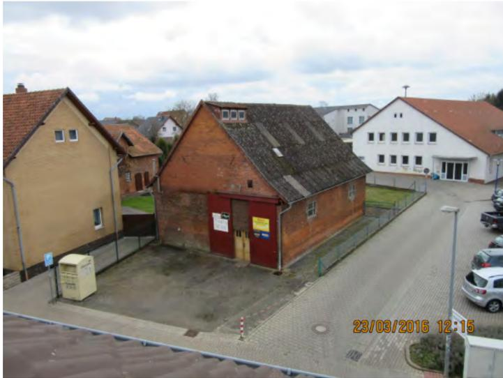
IMG\_0052 Scheune 2: Wellasbest-Dach; Asbestzement-Gaube
