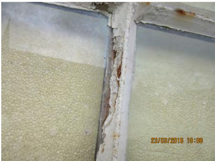
IMG\_0010 Fenster mit asbesthaltigem Kitt
